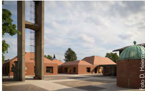
106 Architekturbüro Paul Böhm
